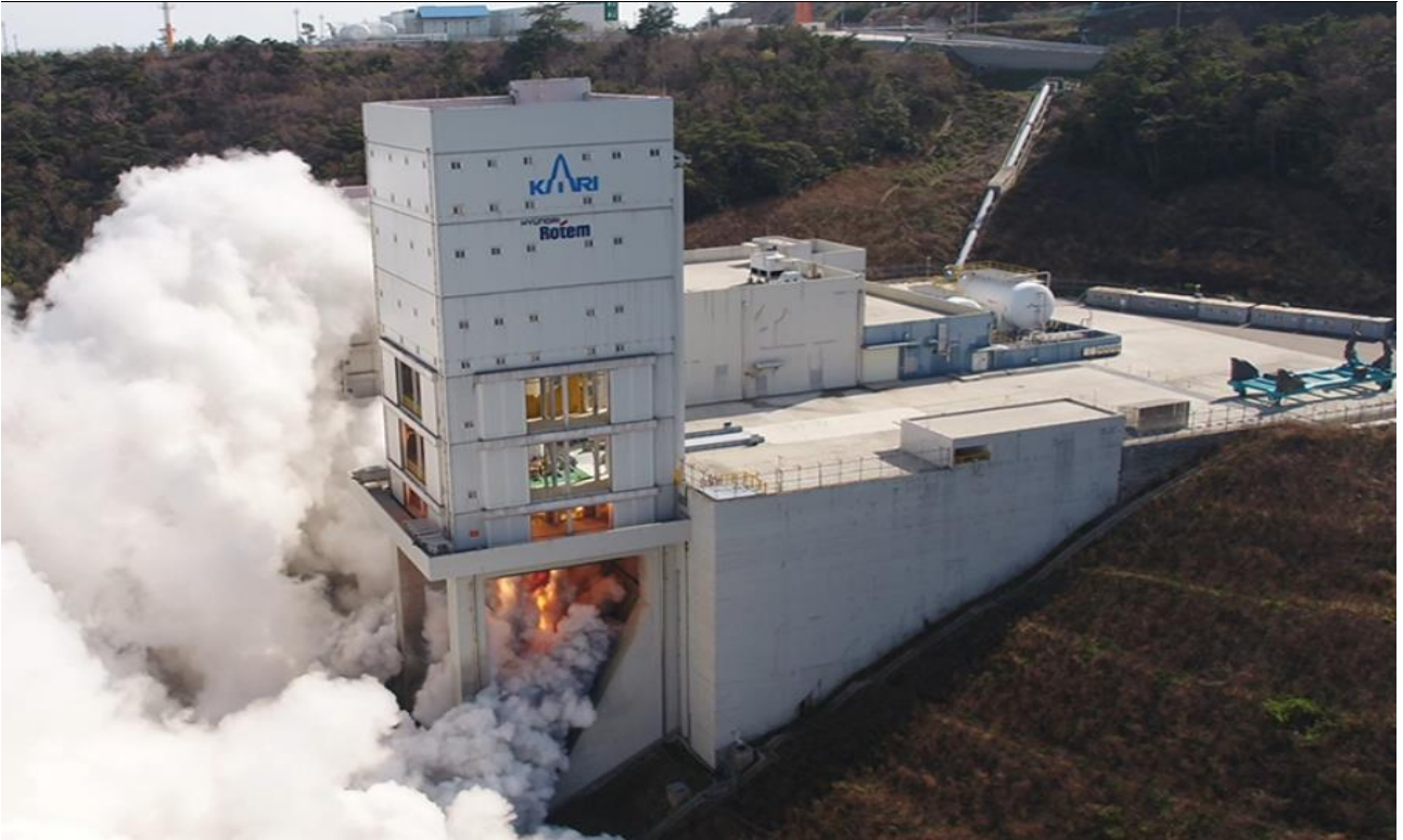
그림10. 현대로템이 구축한 한국형발사체 추진기관시스템 시험설비
